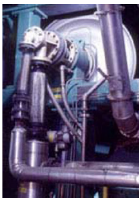
図 10: Johnson Corporationは各種プロセス産業向けシステムを設計しています。
